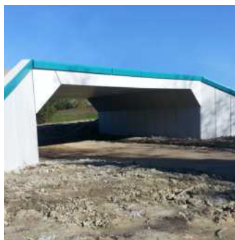
Sottopasso strada poderale
