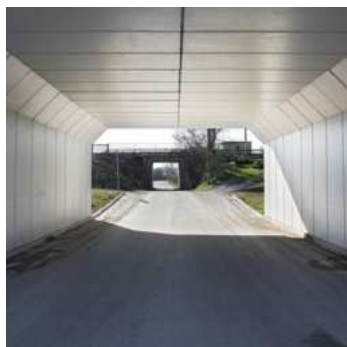
Sottopasso strada Lizzara Nuova
