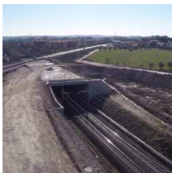
Prolungamento galleria ferroviaria
