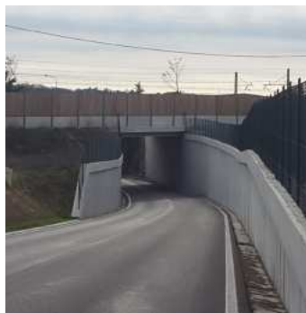
Sottopasso strada S. Cristina
