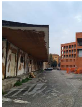
↑ veduta dell'area di intervento prima dei lavori
