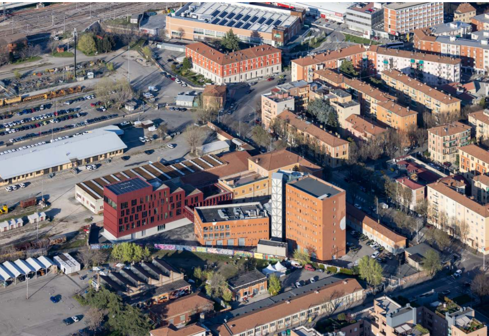
↑ veduta area dell'intervento da sud
