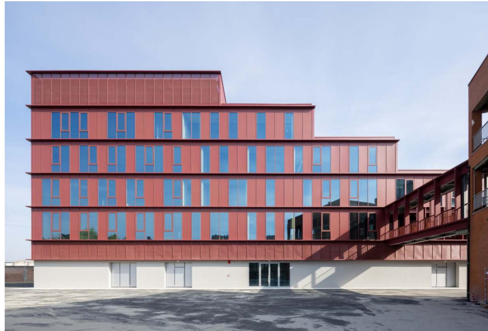
veduta del prospetto sud. A destra, il passaggio pensile verso la mensa
