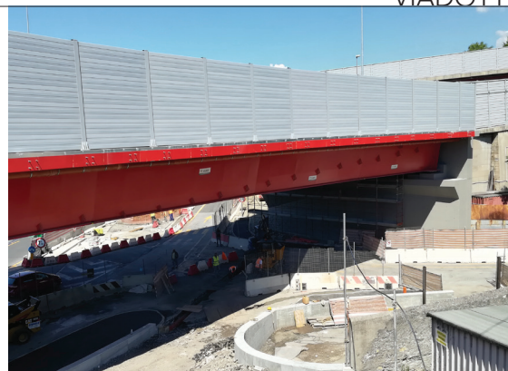
4. La sezione d'impalcato in acciaio
