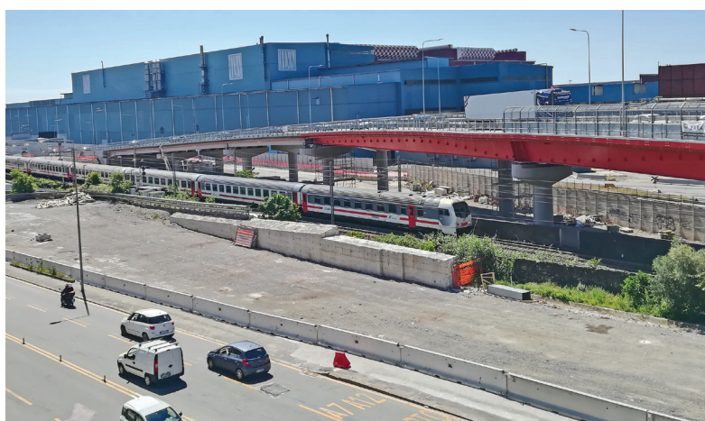
10. Vista laterale del viadotto aperto al traffico verso ILVA
