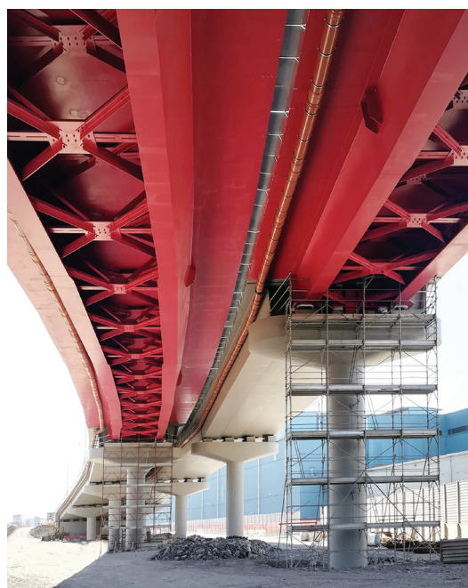
1. Vista del viadotto dall'area sottostante l'impalcato
