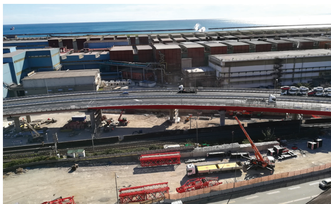
3. Vista aerea del nuovo viadotto in direzione aeroporto
