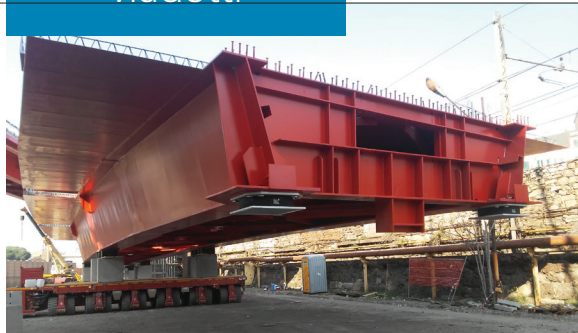
6. Una delle campate a struttura mista, pronta per essere posata
